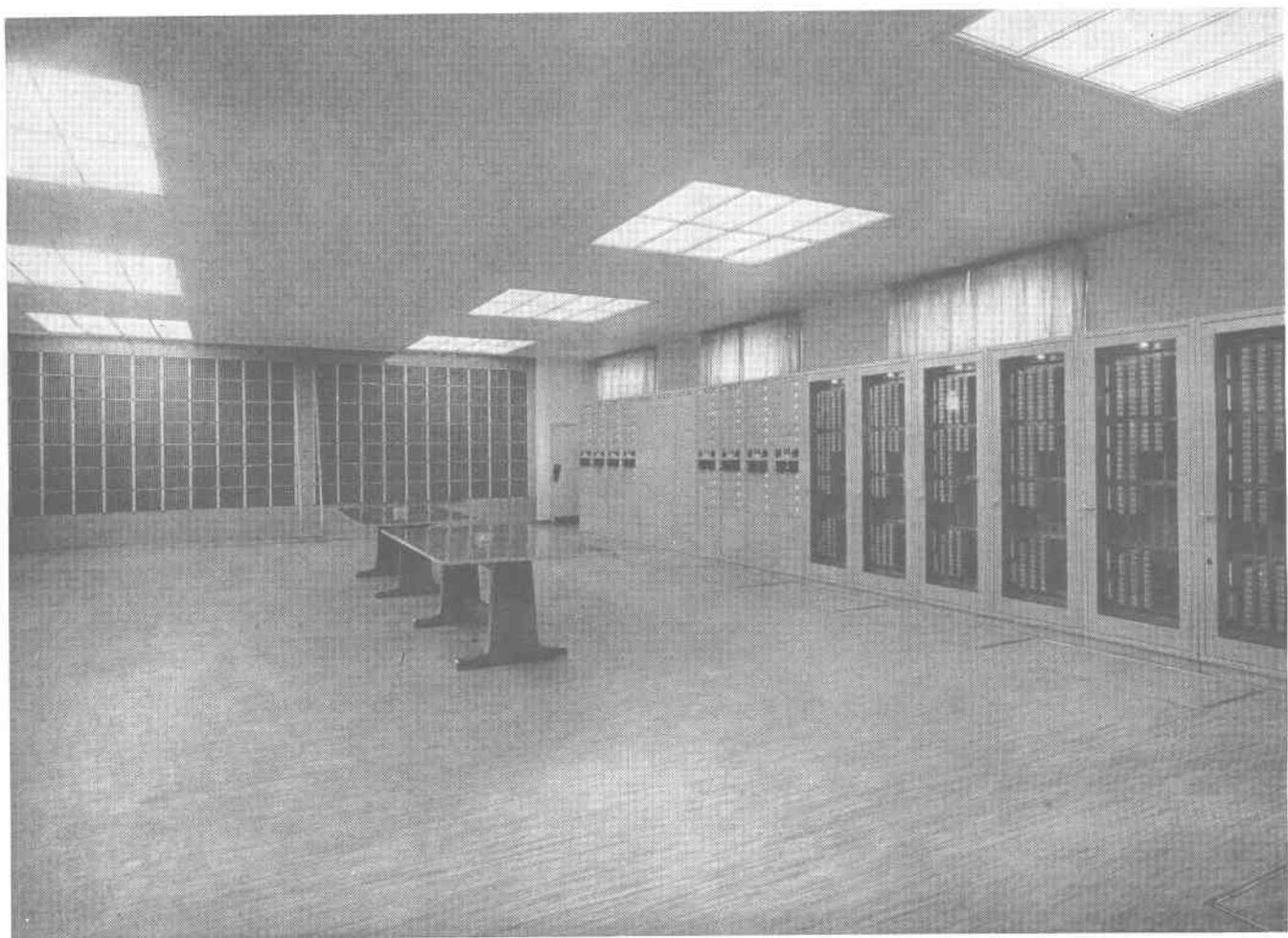
Fig. 12. — Sala centralizzata degli amplificatori delle linee entranti e uscenti e dei corrispondenti relé fonici. Sullo sfondo il permutatore a incroci.
